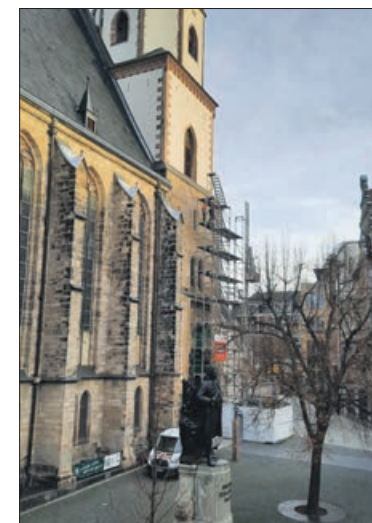
Thomaskirche Leipzig: Abbau der Gerüste am Turm. Foto: Thomaskirche
